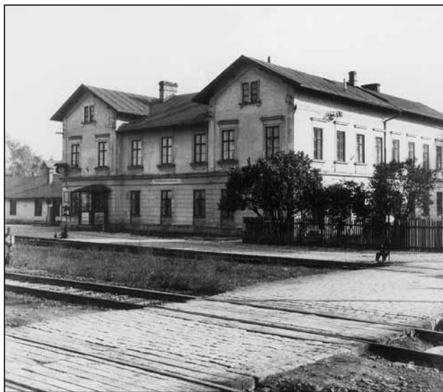
Budova stanice Studénka - místní nádraží v 50. a 60. letech (sbírka M. Leštinského)
